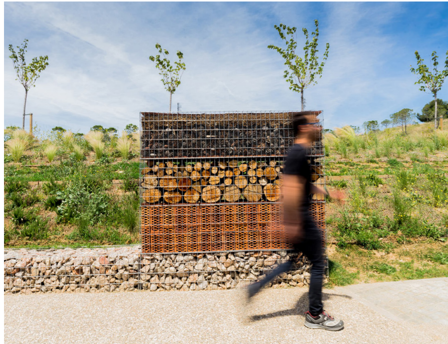
INSEKTHOTELLER UDFØRES PÅ TO SIDER AF TRANSFORMERBYGNING OG I VARIEREDE MATERIALER
